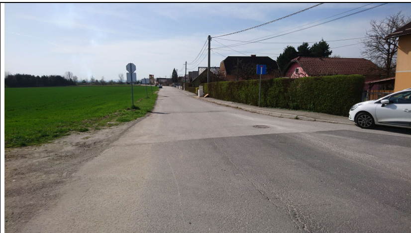
ZAČETEK TRASE OBNOVE LETALIŠKE ULICE PROTI JUGU.
